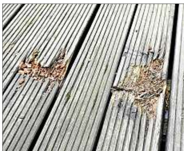
Das Holz der Freilichtbühne ist ob der jahrelangen Witterungseinflüsse weggespreißelt und ruiniert so manchem Besucher Hose oder Kleid. Auf dem rechten Foto sind Reste der zerbrochenen Wasserrohre aus Guss zu sehen. Foto: Theater Erfurt
